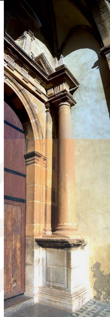
9.- Pilastra del acceso principal
