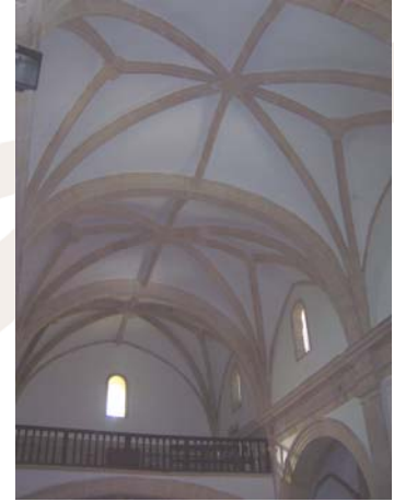
20.- Bóvedas y arcos de la nave central
