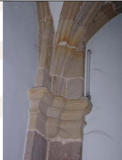
26.- Detalle del arranque de los nervios de la bóveda
