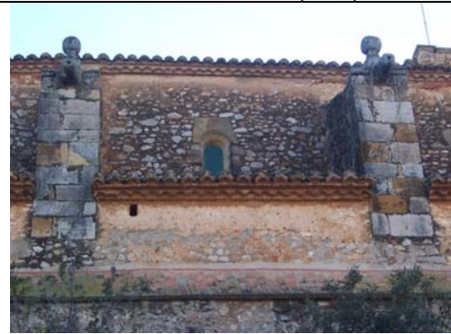
11.-Detalle contrafuertes posteriores
