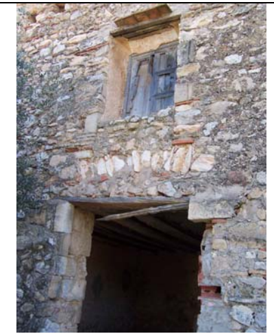
11.- Detalle empedrado y mampostería
