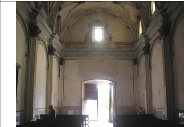
17.- Vista interior del acceso
