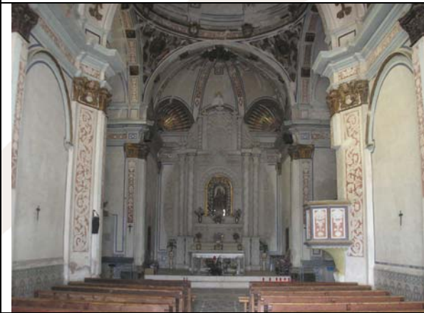
16.- Vista interior de la nave
