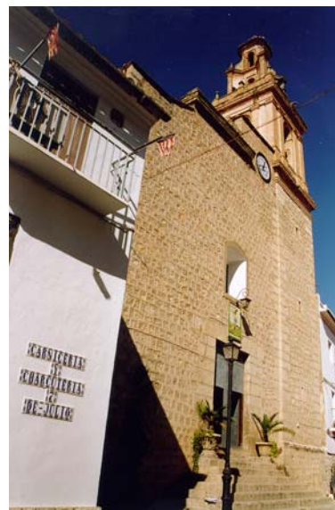
Fachada a la calle San Sebastián.
