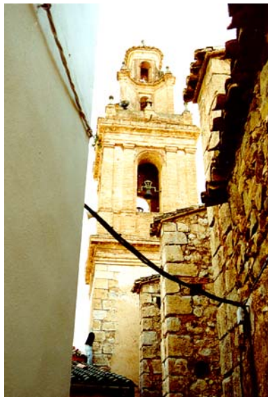
Detalle del Campanario y contrafuertes
