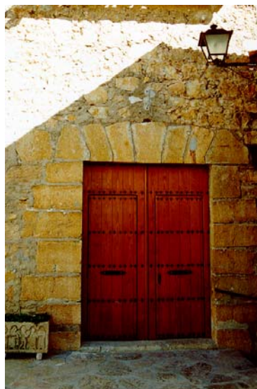
Detalle de la puerta lateral
