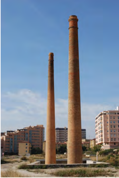
1. Vista general de las chimeneas.
