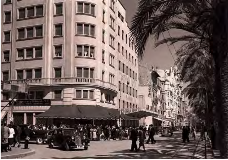
5. Vista histórica de los bajos comerciales.
