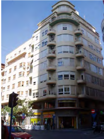
2. Vista general de las fachadas desde la Rambla
