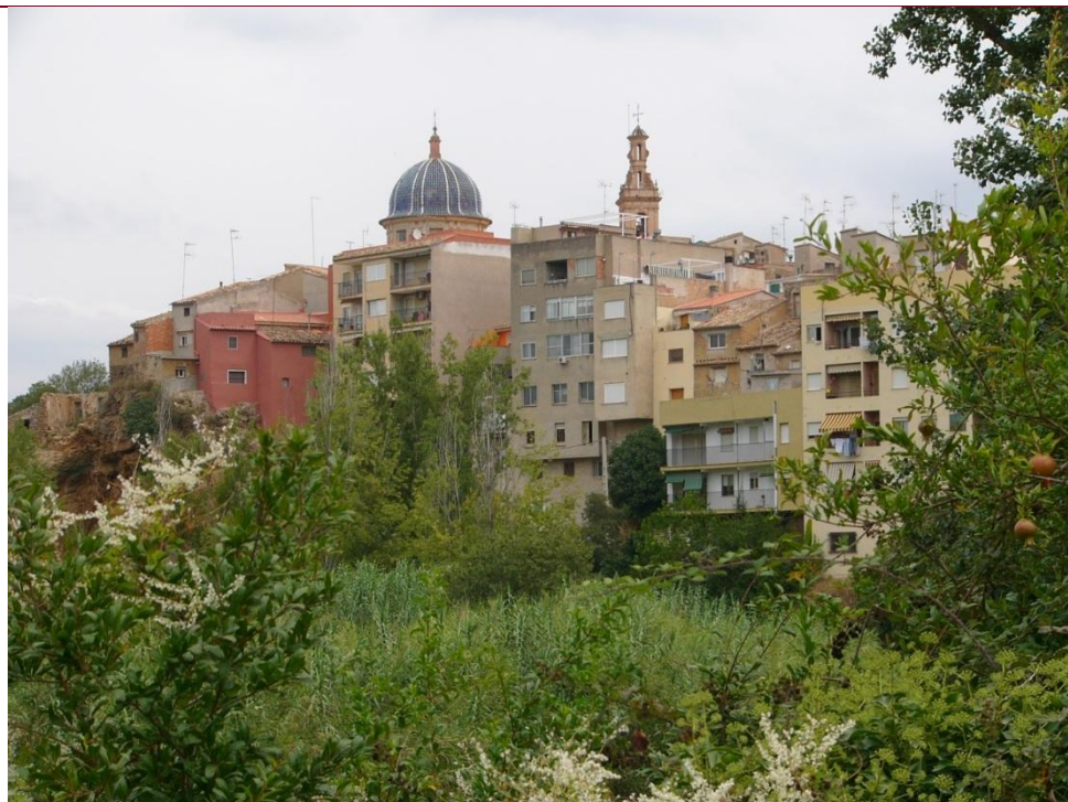
Aspecto de la fachada al río del casco histórico, que conforma el perfil más degradado y necesitado de recuperación paisajística del entorno
