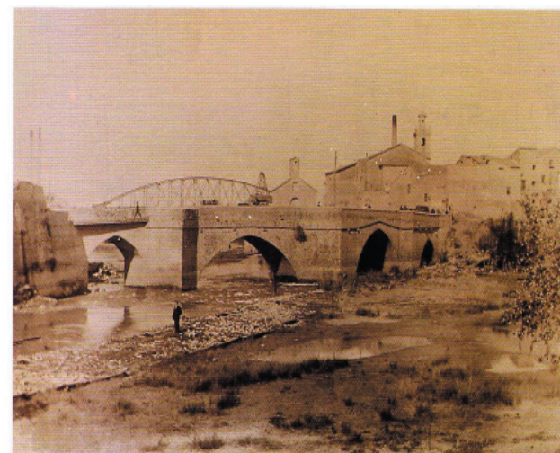
Pont de Santa Maria o de Sant Gregori, sobre el Xúquer a Alcira. Fou el principal i més estratègic pont de les comunicacions valencianes des de l'edat mitjana fins al segle XX, quan s'alçaren diversos ponts metàl·lics sobre el Xúquer. La foto correspon a l'any 1915, poc abans del derrocament i quan ja havien enllestit el pont de ferro per a substituir-lo.
