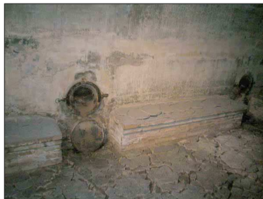
Restos de la maquinaria para renovación del aire
